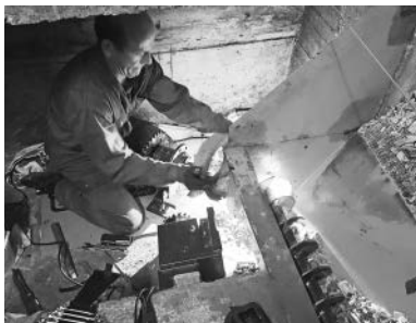
Reparatur Heizungsanlage Frödischsaal
